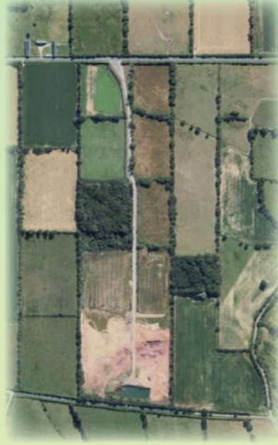
Carrière d'argile de Neuilly-la-Forêt (14) en exploitation en 2005 (Source : Google Earth)
